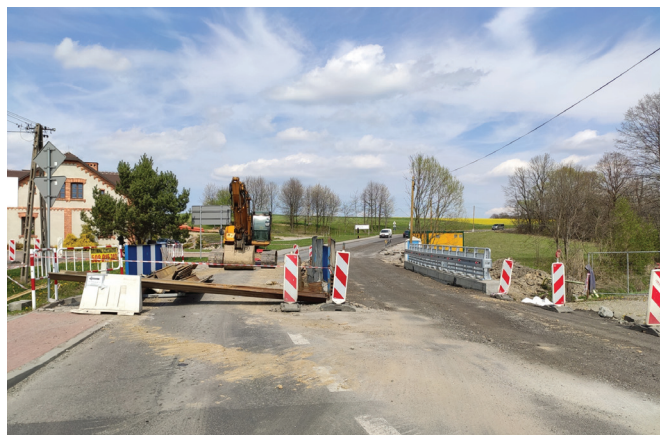
Remont mostu na ul. Krakowskiej w Bestwinie
